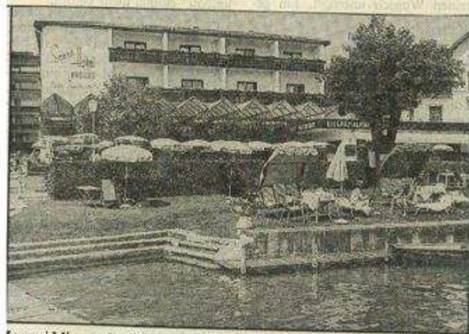
In zwei Minuten ist die Terrasse per Knopfdruck überdacht. Das Gigantische dabei ist, daß 4000 kg auf 240 Rollen bewegt werden.
